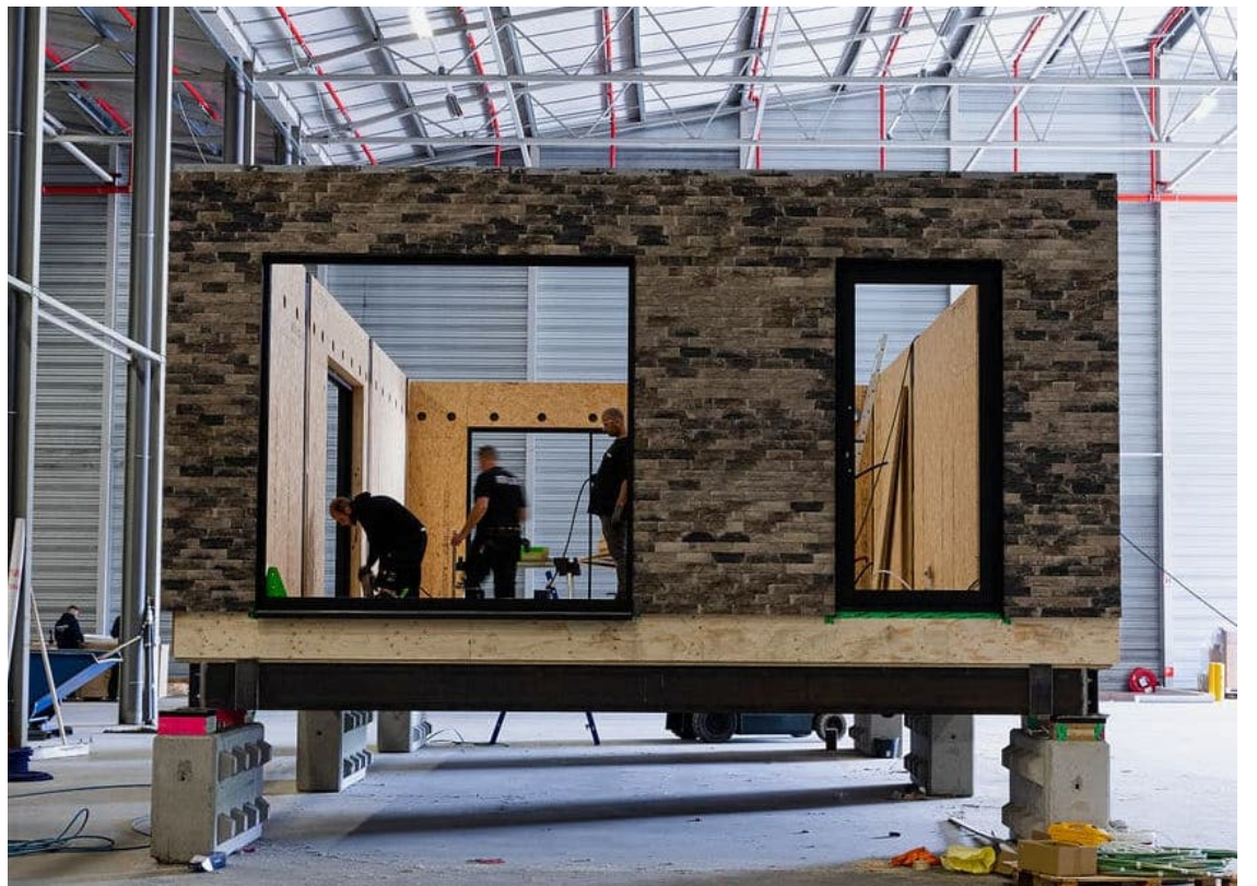
In amper vijf weken tijd kan Kepler een volledige woning bouwen. Die is betaalbaar en héél energiezuinig. © RR
